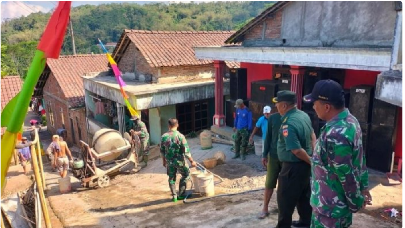
Kasdim Magelang Cek pengerjaan sasaran fisik TMMD sengkuyung di Kecamatan Bandongan
