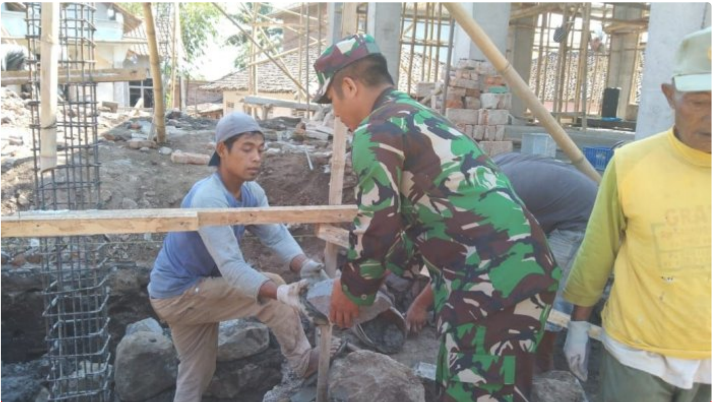
Serda Nasikin bantu pemasangan batu pondasi masjid
